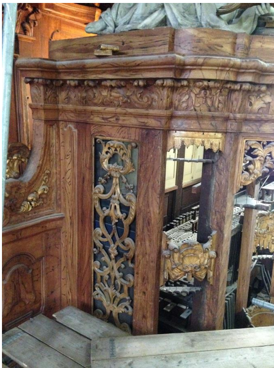
Bij de demontage van een groot orgel wordt het inwendige gedemonteerd. De kas blijft op zijn plaats (Amsterdam, Oude Kerk).
