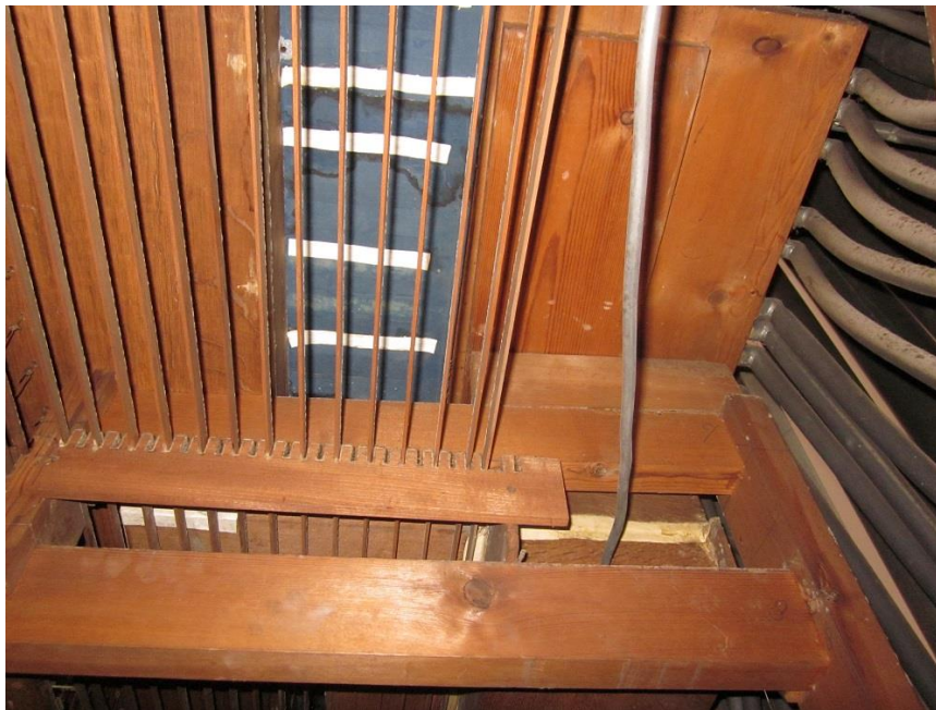
De onderkant van een windlade. De lade is aan de onderkant beplakt met blauw papier, de witte leerbanen zijn provisorische reparaties van scheuren of opengetrokken naden.
