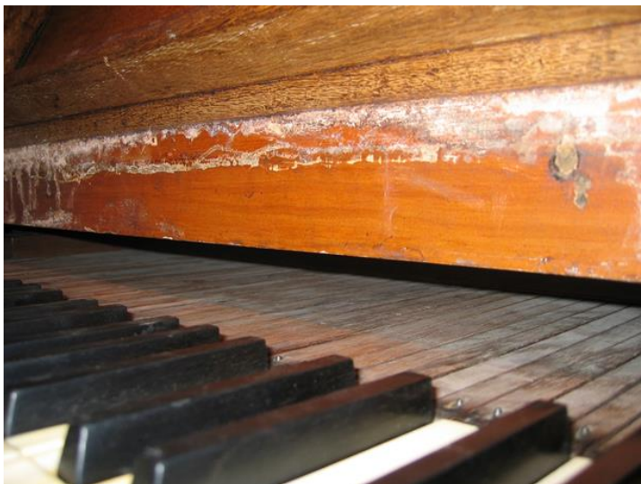
Op plaatsen die normaalgesproken niet zichtbaar zijn, zoals hier de lijst achter het klavierplankje, blijven soms sporen van een oude, kleurige afwerking bewaard (Amsterdam, Ons' Lieve Heer op Solder).
